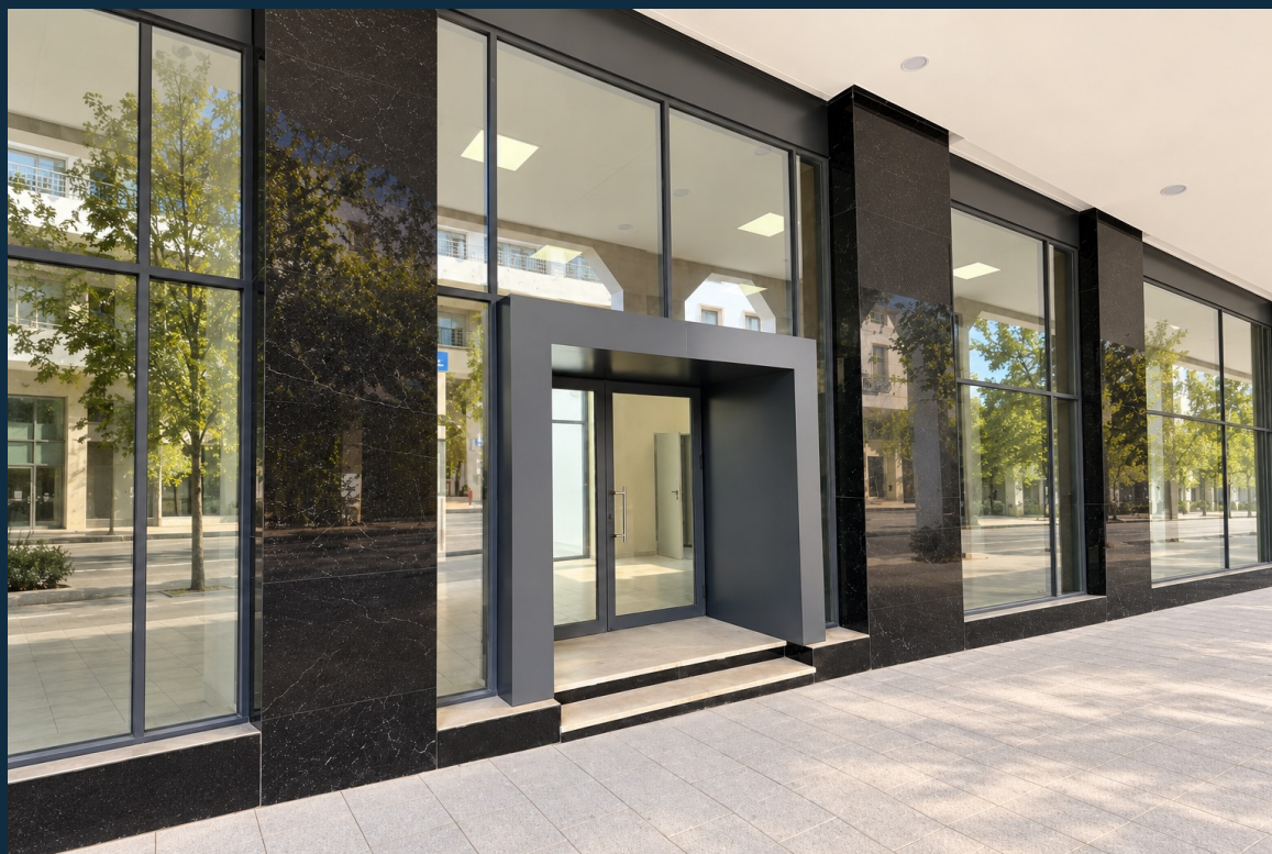
L'ENTRÉE · MÉTAL ET VITRAGE
